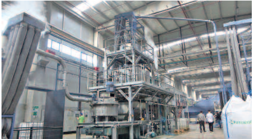
Ein Herzstück der PET-Recycling-Anlage ist die Heißwäsche (Alle Bilder: Futurapet/Herbold Meckesheim)
