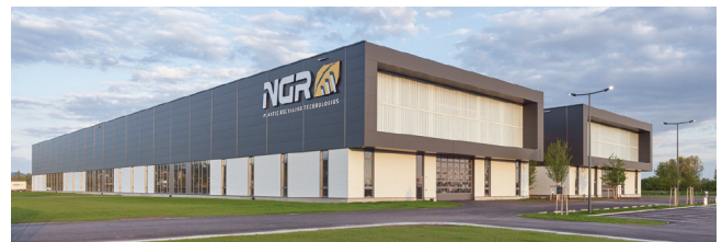
Das neue energieeffiziente NGR-Werk in Feldkirchen/Donau (Foto © Kurt Hörbst)
