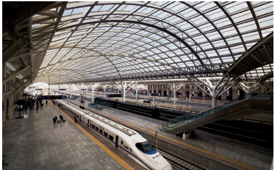
Bahnhofsüberdachung mit Exolon® UV (Foto: Exolon Group)
