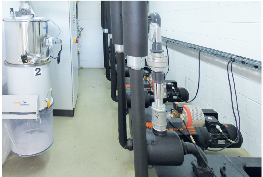
Klauen-Vakuumpumpen sind für lange Strecken geeignet
