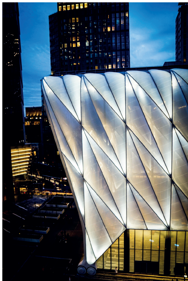
Die Fassade der ausfahrbaren Halle erhält mit transluzenten Folienkissen aus 3M Dyneon Fluoroplastic ETFE ein unverwechselbares Erscheinungsbild (Foto: 3M/ Shutterstock)
