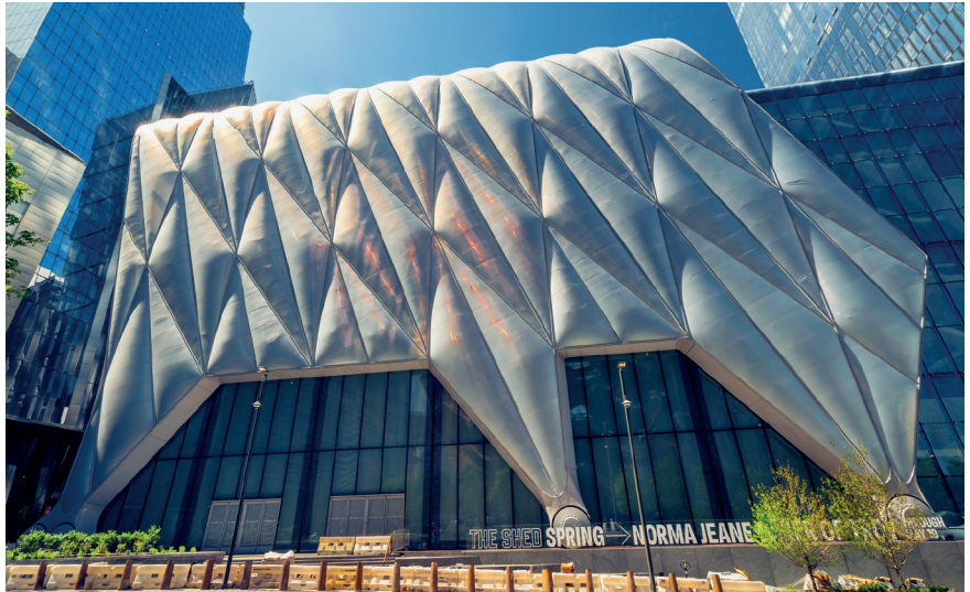
Die filigrane Konstruktion mit dreilagigen Folienkissen wiegt 95 Prozent weniger als Glas (Foto: 3MI Shutterstock)
