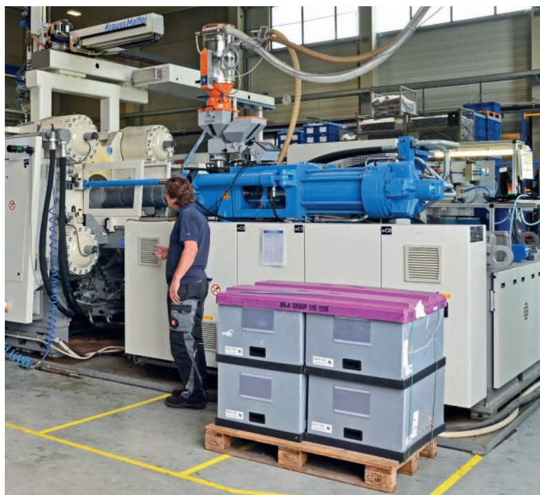
13 Trockentrichter halten die bei FKT gebräuchlichen Werkstoffe in optimaler Verarbeitungsqualität vor, von hier gelangen sie über die zentrale Förderanlage an die Spritzgießmaschinen (Bilder: motan-colortronic)
